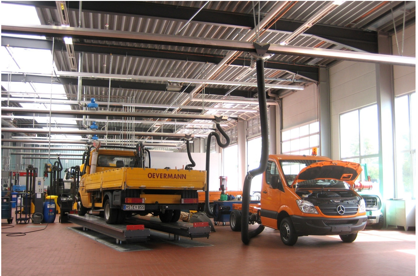
Saugschlitzkanal für Lkw
