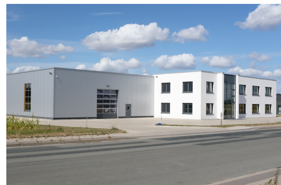
Neubau Halle und Büro
