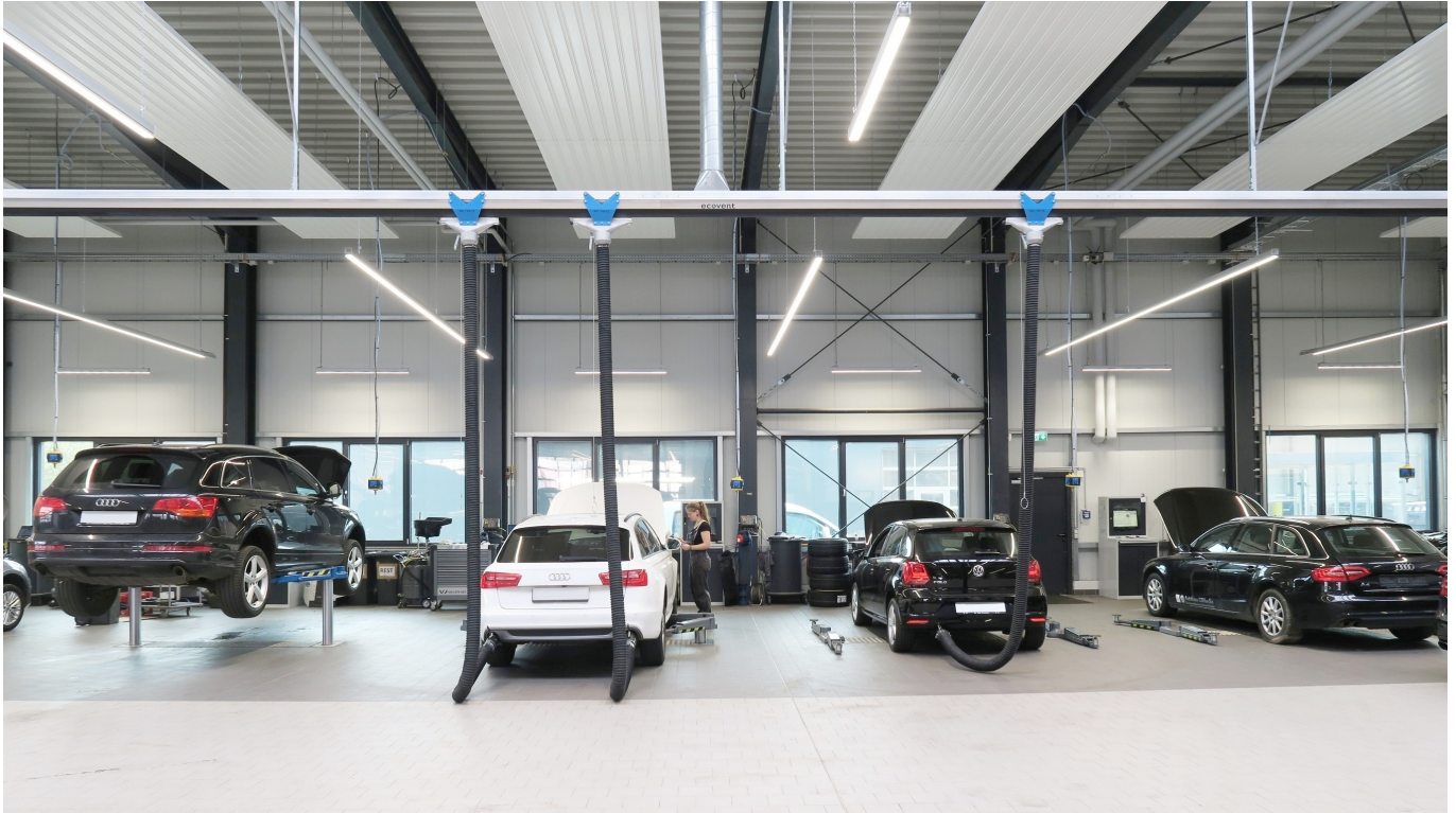
Saug Schlitzkanalanlage in einer Volkswagen- und Audi-Werkstatt
