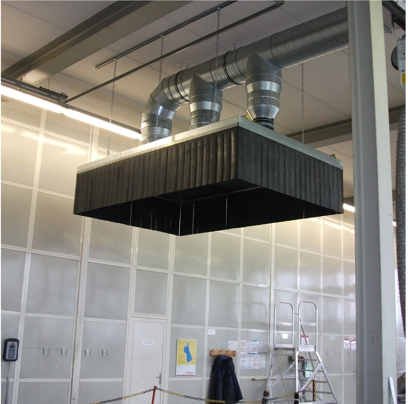
Absaughaube für Motorendämpfe
