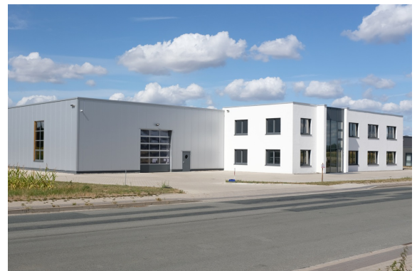
Neubau Halle und Büro
